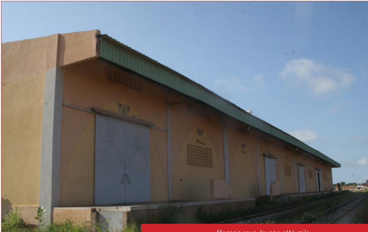
Magasin sous douane côté rails
