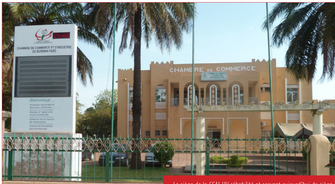
Le siège de la CCAI-HV réhabilité et servant aujourd'hui de siège à la Direction Régionale de Bobo-Dioulasso
