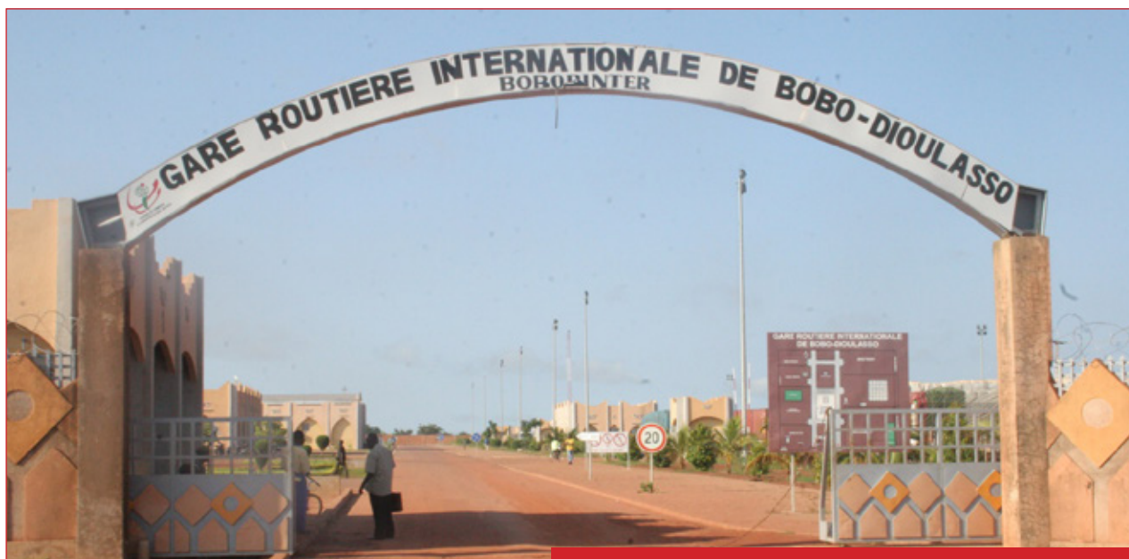
Entrée principale de Boborinter
