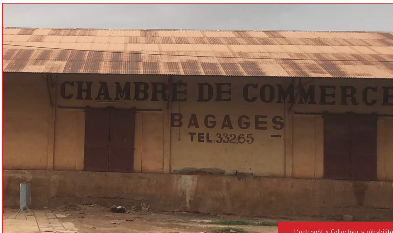
L'entrepôt « Collecteur » réhabilité
